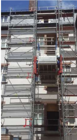
Ein Lastenaufzug ist außen am Gebäude angebracht
